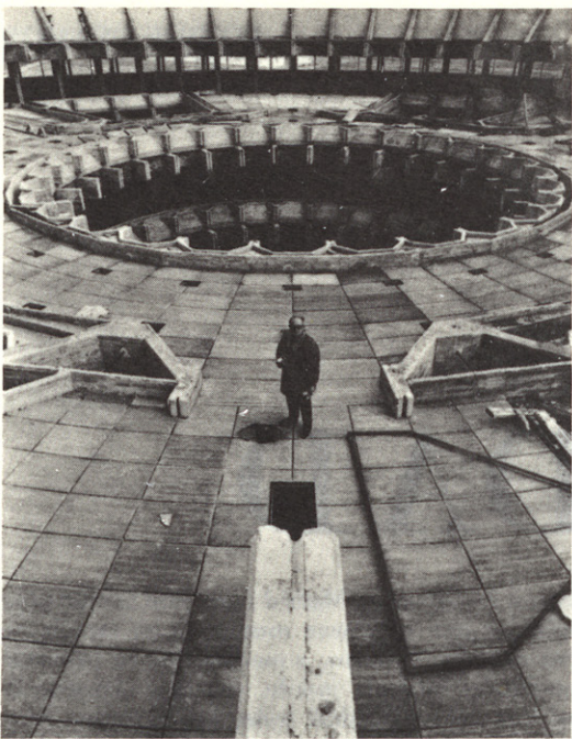
El fotógrafo Francisco Gómez en la terraza del edificio
