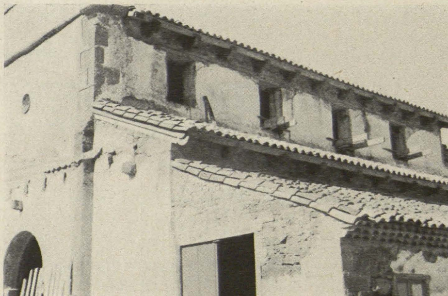
Priesca (Villaviciosa): Detalle de aleros reconstruidos en el costado de la Epístola.
