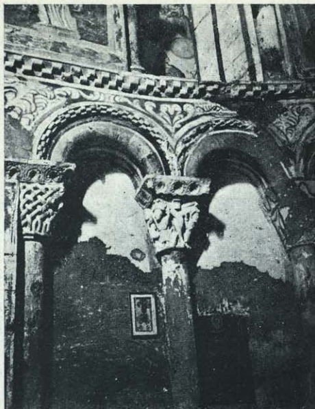
DETALLE DEL INTERIOR DEL ÁBSIDE.
